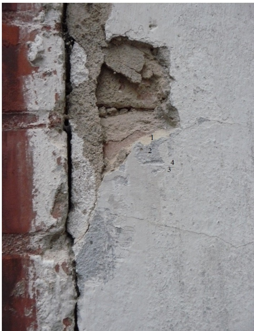
Fot. 38. Ogrodzenie od strony wnętrza przy północnej elewacji w partii przybudówki. Odkrywka nr 14 i miejsce pobrania Próbki 17 . Mury nie są przewiązane.
