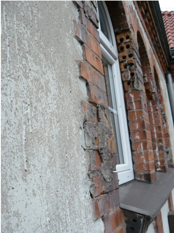
Fot. 5. Zniszczenia opasek okiennych. Wtórne metalowe parapety. Elewacja północna.
