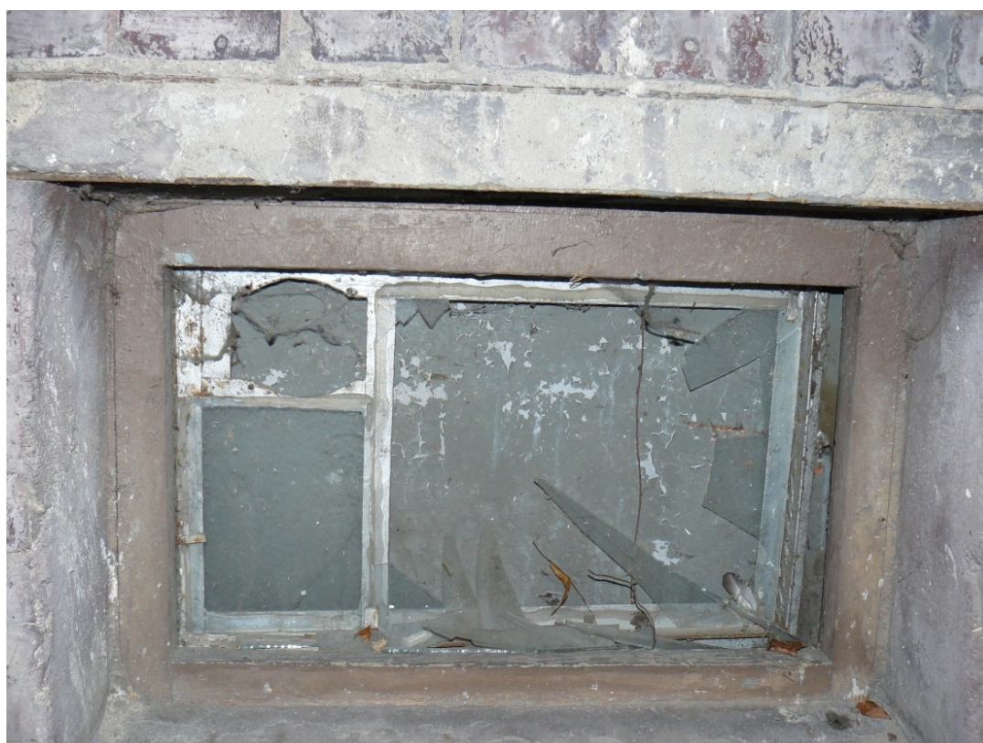
Fot. 41. Elewacja południowa. W drewnianej ramie osadzona jest ślusarka okienna. Elementy wtórne. Odkrywka nr d_1 i miejsce pobrania Próbki 5 na ościeżnicy.
