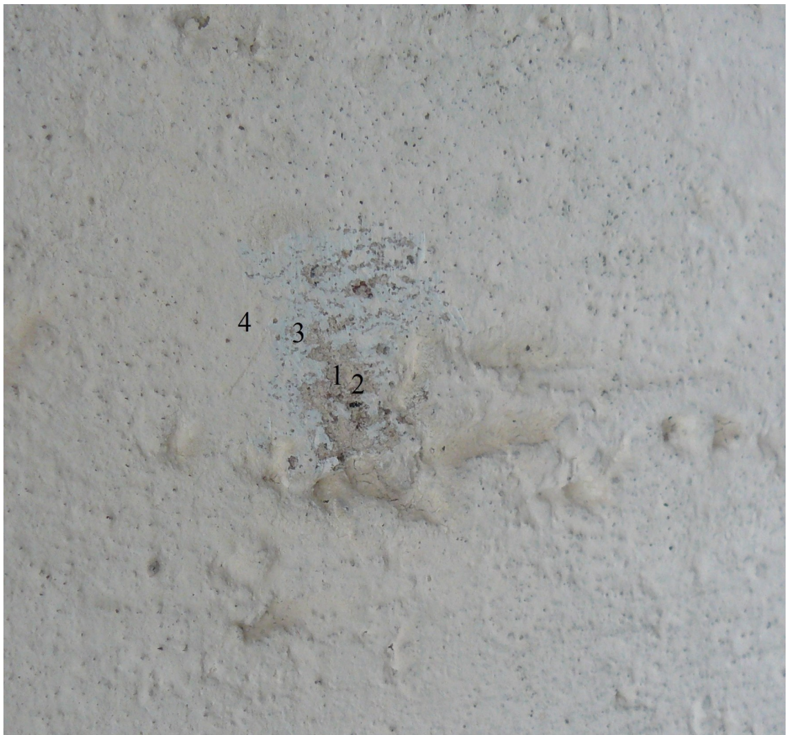
Fot. 29. Elewacja północna. Trzecia kondygnacja. Odkrywka nr 9 na płycinie. Widoczna stratgrafia nawarstwień na fakturalnym tynku, podobna jak w Odkrywce nr 8 .
