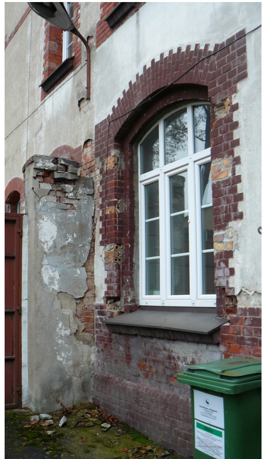
Fot. 8. Zły stan zachowania elewacji zachodniej przy murze ogrodzenia dziedzińca zewnętrznego..
