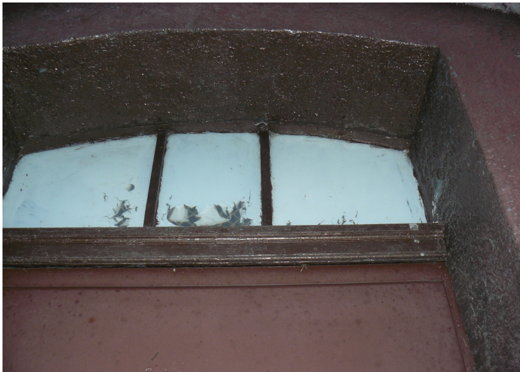
Fot. 49. Elewacja północna. Nadświetle należące najstarszego wyposażenia stolarki drzwiowej. Odkrywka nr d_4 i miejsce pobrania Próbkki 13.
