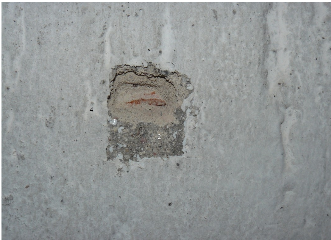
Fot. 12. Elewacja wschodnia. Odkrywka nr 1 i miejsce pobrania Próbki 1 . Na tynku szarawa warstewka przypuszczalnie przeklejonego brudu.
