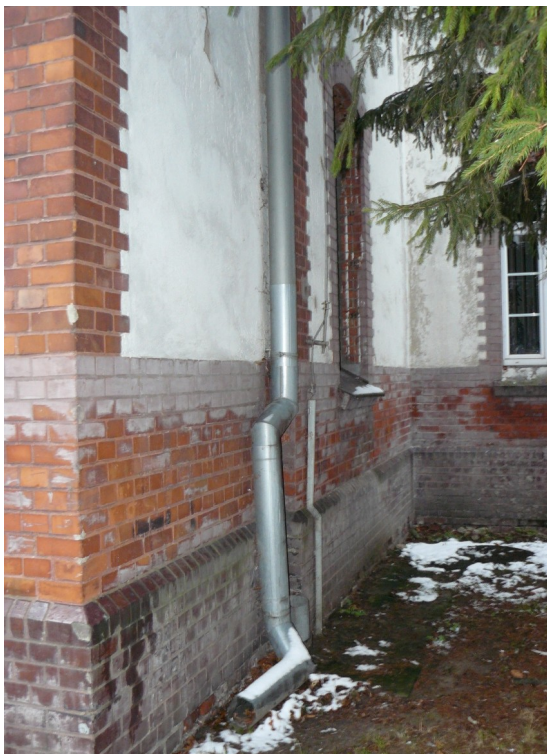
Fot. 7. Widoczne wtórne nawarstwienia farb, zabrudzeń na elementach ceglanych oraz spęcherzenia tynku. Elewacja południowa.
