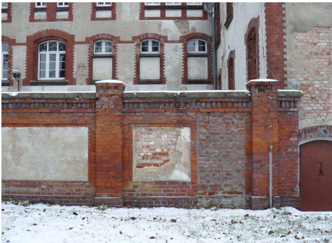
Fot. 20. Elewacja zachodnia. Ogrodzenie dziedzińca zewnętrznego. W segmencie widoczne zamurowanie wtórnego otworu przejściowego zakłócające rytmikę podziałów. Miejsce usytuowania Odkrywki nr 5 .
