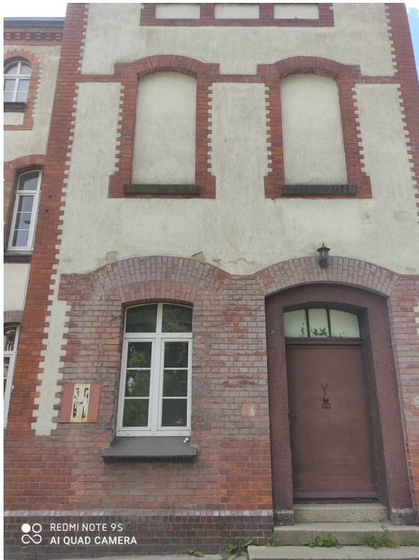
Fot. 9. Zachowało się pierwotne nadświetle stolarki drzwiowej w elewacji północnej. Ślusarka drzwiowa wtórna.
