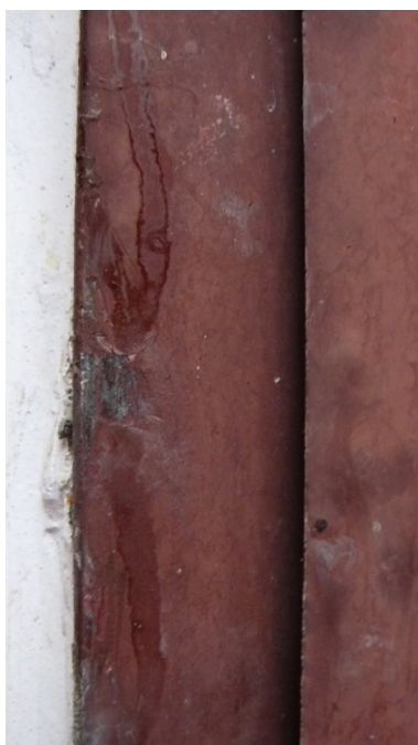
Fot. 53. Ślusarka. Rdzawobrazowa powłoka leży na metalu.
