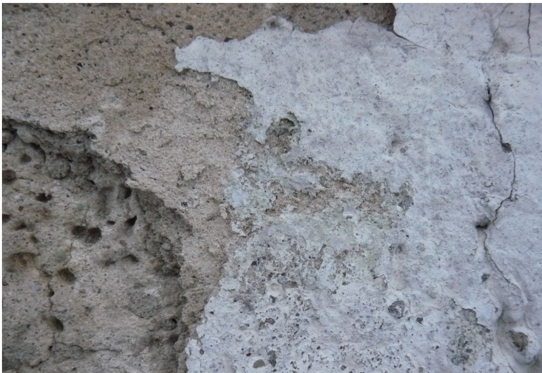
Fot. 21. Murowane ogrodzenie od strony zewnętrznej. Odkrywka nr 5 i miejsce pobrania Próbki 7 . Widoczne grube nawarstwienia tynków z dodatkiem cementu.
