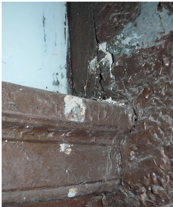
Fot. 32. Elewacja północna. Ościeże otworu wejściowego z drewnianym nadświetlem. Odkrywka nr 11 i miejsce pobrania Próbki 14 . Widoczna Odkrywka nr d 1 na nadświetlu.
