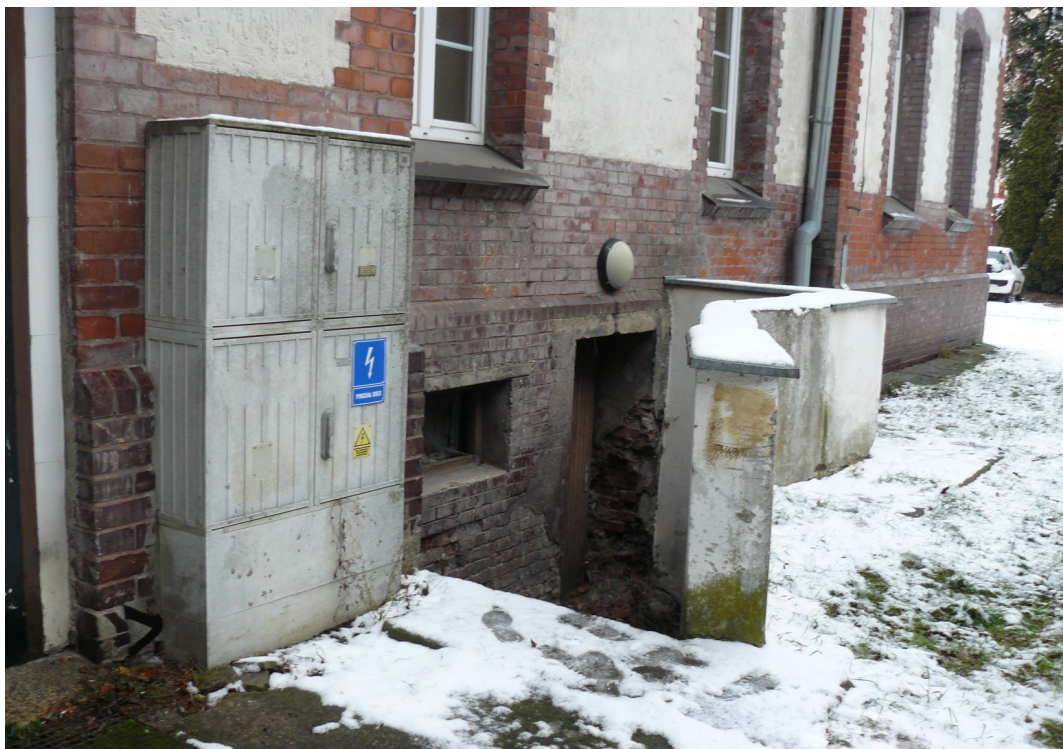
Fot. 40. Elewacja południowa. Widoczne wtórnie wykute wejście i otwór okienny do piwnicy.
