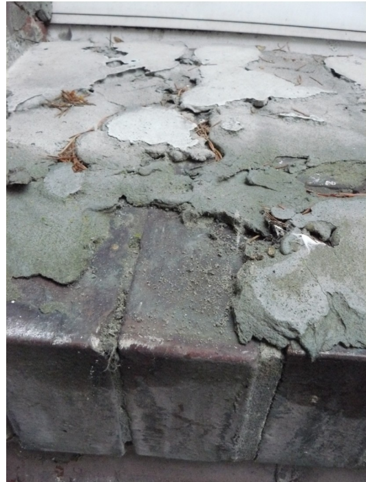
Fot. 6. Parapety zewnętrzne z wtórnymi cementowymi zaprawami
